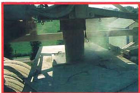
Cargar la tolva de cemento por silo
