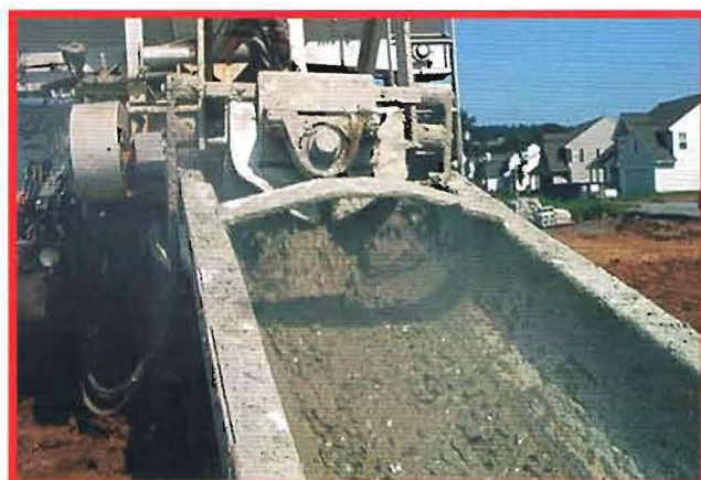
El hormigón sale del transportador del bisefín y entra en el canal de descargo
