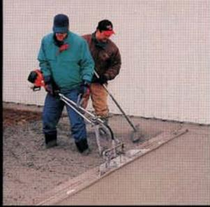
Es la única regla vibradora del mercado cuya vibración se transmite de abajo hacia arriba (Compactación horizontal).
