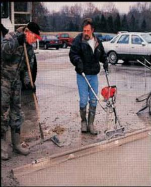
Es la única regla vibradora del mercado cuya vibración se transmite de abajo hacia arriba (Compactación horizontal).
